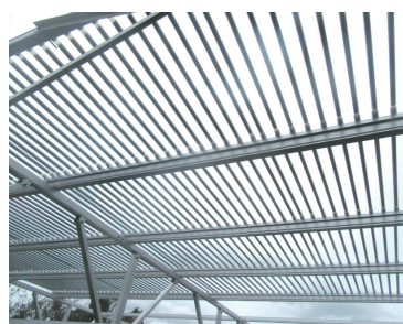
円筒形太陽電池を屋根に設置した様子
